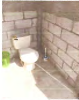
SUSTITUCION DE SERVICIOS SANITARIOS Y SUS ACCESORIOS
