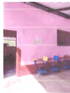
PINTURA, PINTURA EN MUROS EXT E INTERIORES
