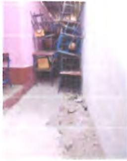
LOSA DE PATIO, SUSTITUCION LOSA DE PISO EN MAL ESTADO
